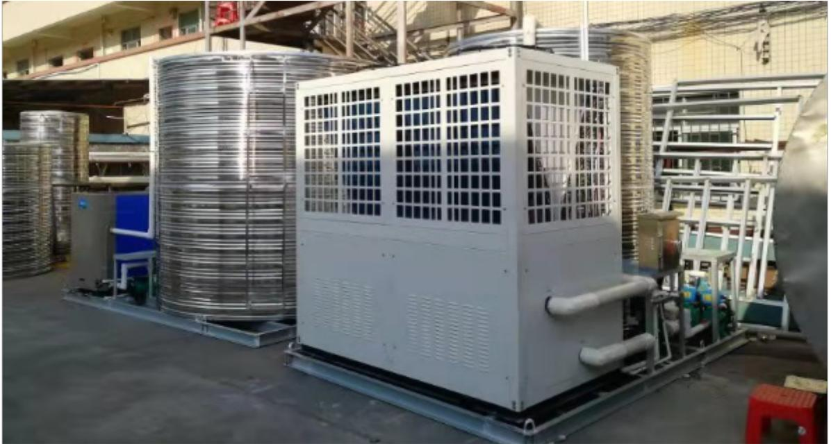
得到QB+QA突破传统单一不同能之间转变无法达到100%效率的瓶颈；采用热泵技术能效比更高。空气能热水器工作原理编辑空气能热水器是按照“逆卡诺”原理工作的，具体来说，就是“室外机”作为热交换器从室外空气吸热，加热低沸点工质（冷媒）并使其蒸发，冷媒蒸汽经由压缩机压缩升温进入水箱，将热量释放至其中的水并冷凝液化，随后节流降压降温回到室外的热交换器进入下一个循环。简单来说是吸收空气中的热量来加热水，被吸收热量的空气也可被运用到厨房，解决闷热问题。空气能热水器优点编辑1、节能毋庸置疑，空气能热水器大的优点就是节能。将空气中的低温热能通过压缩机转化为高温热能，以相同的热热水制造量为基准，和电热
